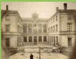
> Groupe scolaire de la grande rue de la Guillotière, s.d.
